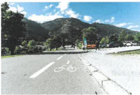
2022 Mehrzweckstreifen zwischen Gehsteig und Fahrbahn
